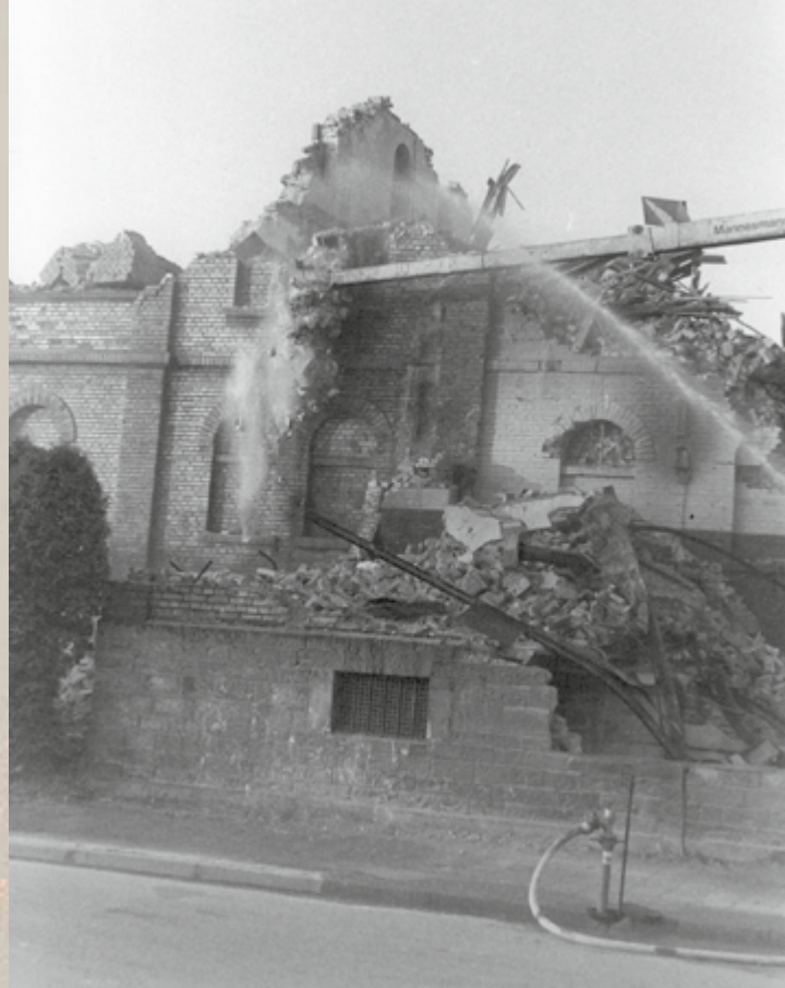
Viel Wasser hilft gegen Staub beim Abriss.
