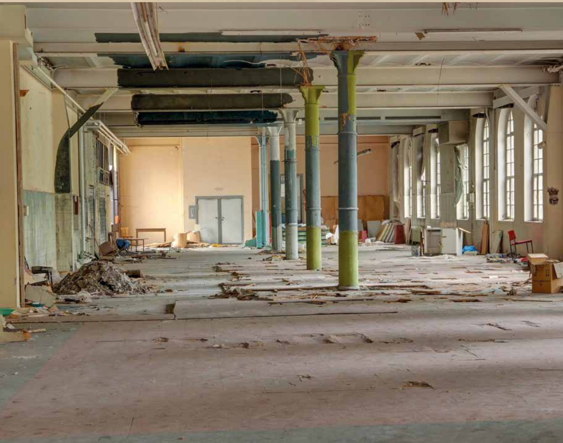
Ehemaliger Arbeits- und Lagerraum.
