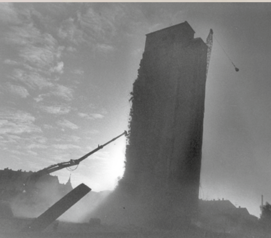
Die Abrissbirne verrichtet im Abendlicht ihr zerstörerisches Werk.
