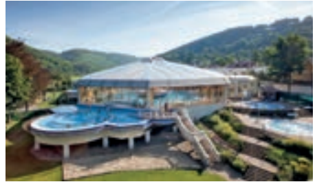
Außenbereich der Weser-Therme.
