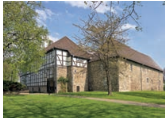
Die von Wassergräben umgebene Domänenburg Aerzen wurde 1293 erstmals urkundlich erwähnt.
