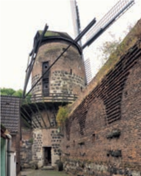
Die Zonser Windmühle ist Bestandteil der alten Stadtbefestigung.
