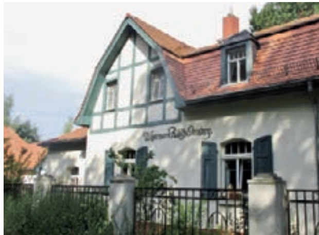
Das Wasserwerk mit Pumpenhaus, ein technisches Denkmal, liegt abseits im Wald.
