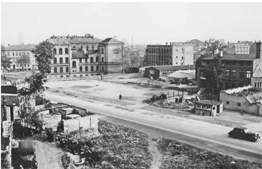
Trümmerräumung und Wiederaufbau im Königsweg. Blickrichtung Ringstraße mit dem Amtsgericht, 1950.
