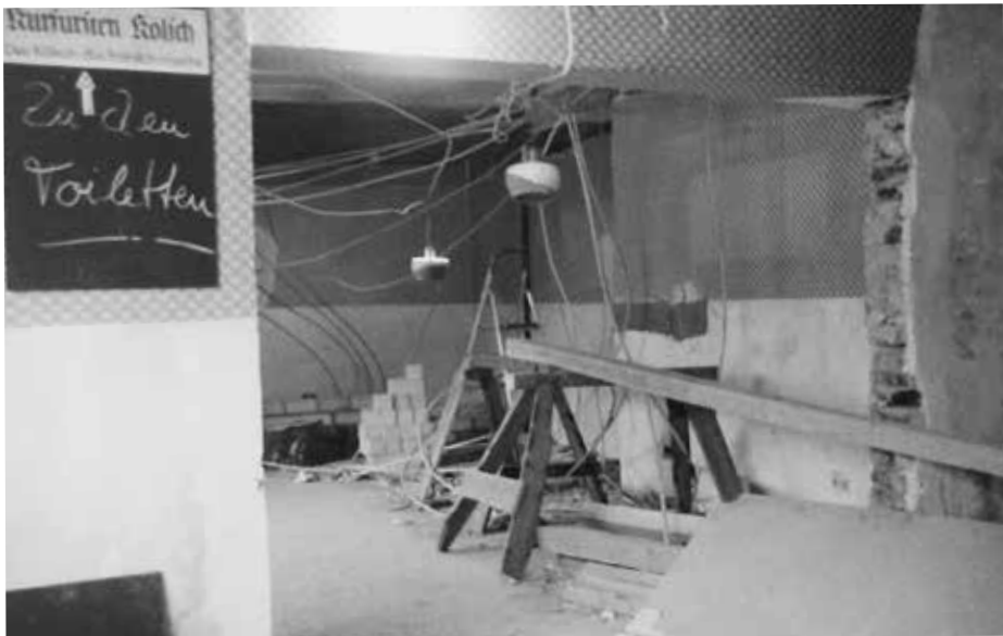
Der Betrieb lief trotz Baustelle weiter. „Heute hätte das Ordnungsamt das niemals durchgehen lassen“, sagt Anne Wibbe.
