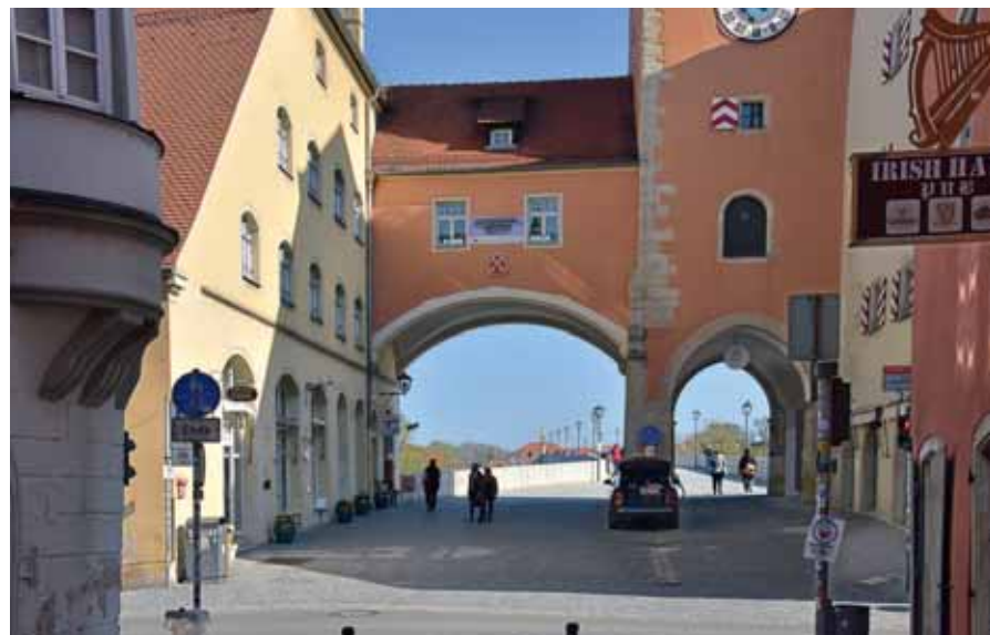
Heute ist die Brückenauffahrt verkehrsfrei.
