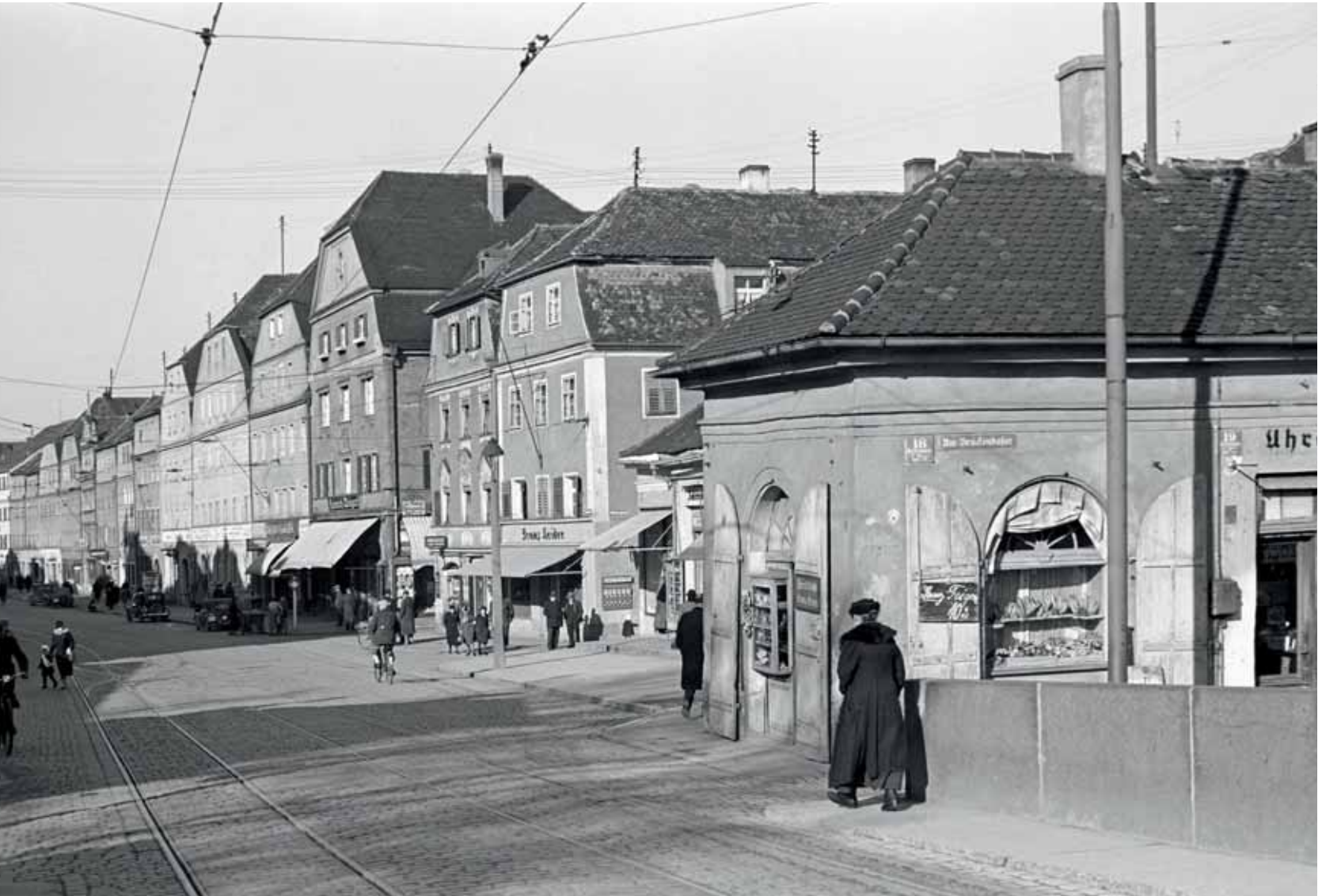
Rechts im Bild der östliche Teil des Brückenbasars im Jahr 1939.
