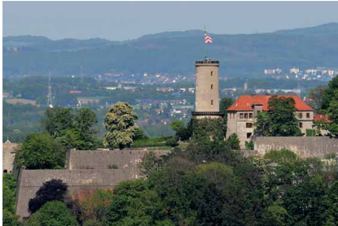
Blick auf die Gesamtanlage von Westen
