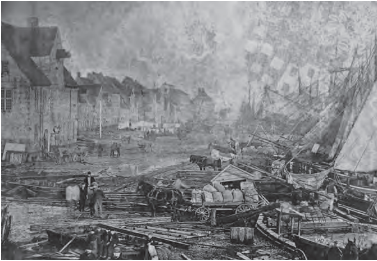
Der Flensburger Hafen nach der Sturmflut – alles ist zerstört.
