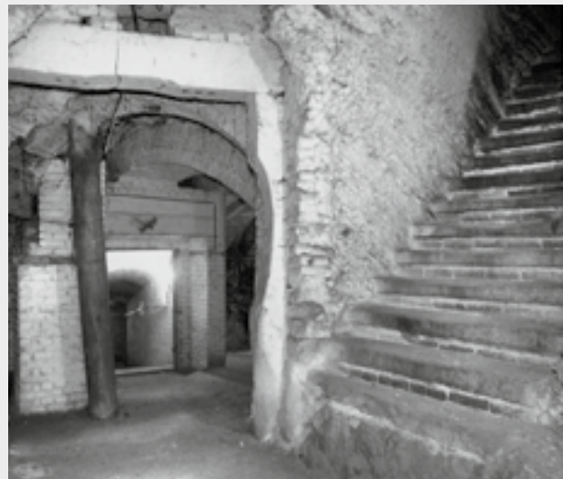
Blick in den Weinbergbunker. Hier suchten viele Menschen Schutz.
