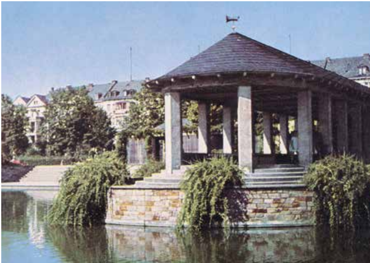
Die schiefergedechte Pfeilerhalle aus Sonnenberger Bruchstein wurde in Querrichtung zu dem 100 Meter langen Wasserbassin errichtet. Im Hintergrund die Häuser an der Bahnhofstraße. Beide Aufnahmen entstanden 1938.
