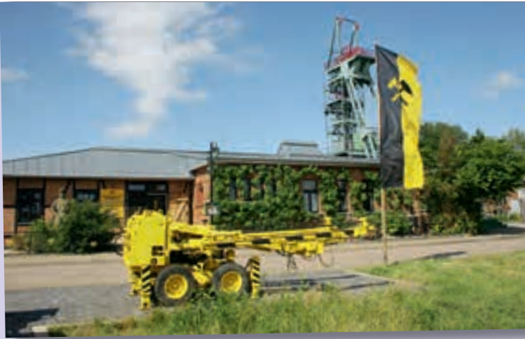
Das ehemalige Kupferschiefer-Bergwerk Röhrigschacht erhält die Traditionen des Mansfelder Kupferschieferbergbaus. Zum „ErlebnisZentrum Bergbau Röhrigschacht Wettelrode“ gehört ein Bergbaumuseum mit Schaubergwerk. Hier steht auch das älteste Fördergerüst Europas.
