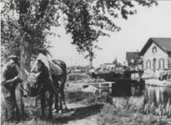
Noch ist der alte Ludwig-Donau-Kanal in Betrieb: Der Treidelgaul nimmt Futter zu sich, während der Treidelkahn in der Dooser Schleuse an der Stadtgrenze liegt.
