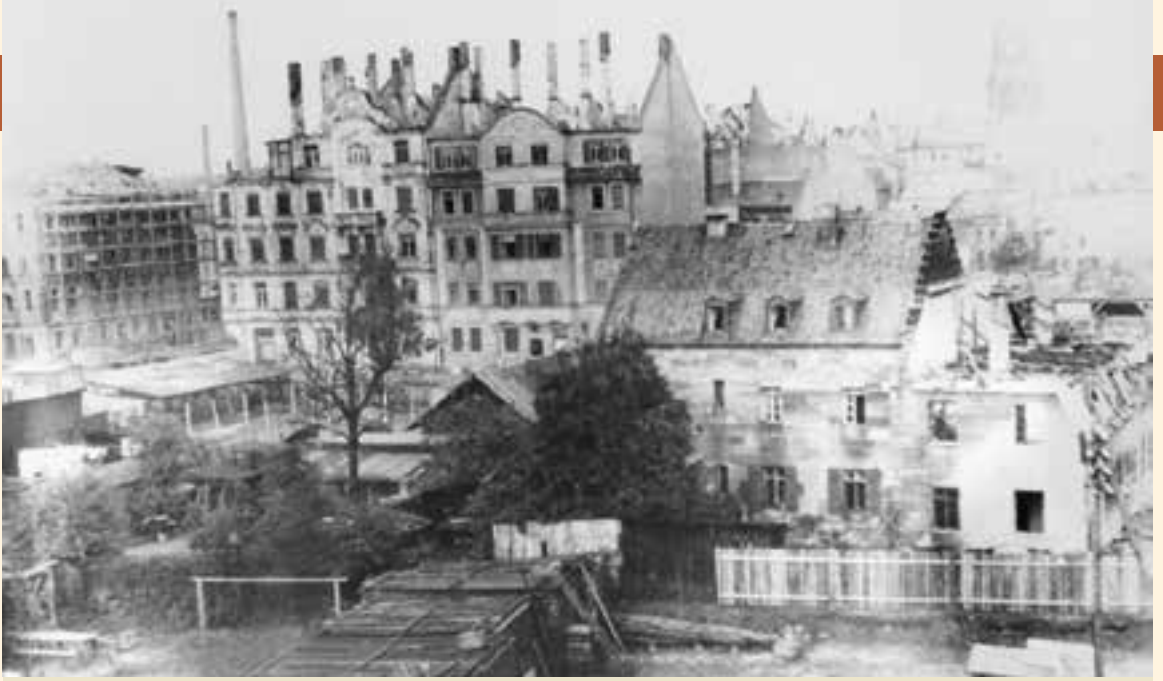
Zerstörte und beschädigte Häuser an der Amalien- und Ludwigsstraße.
