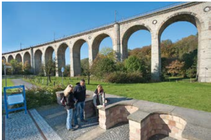
Das Viadukt von Altenbeken
