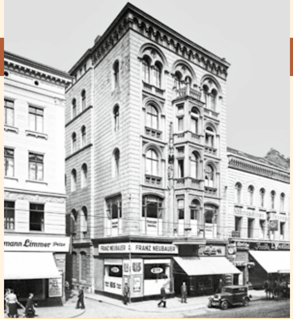
Das Eckhaus Dreienelstraße 1 /Breiter Weg vor der Zerstörung.
