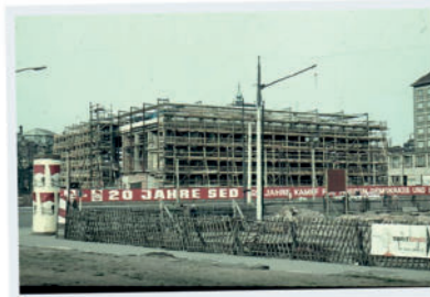
Der Fresswürfel im Bau, 1966.
